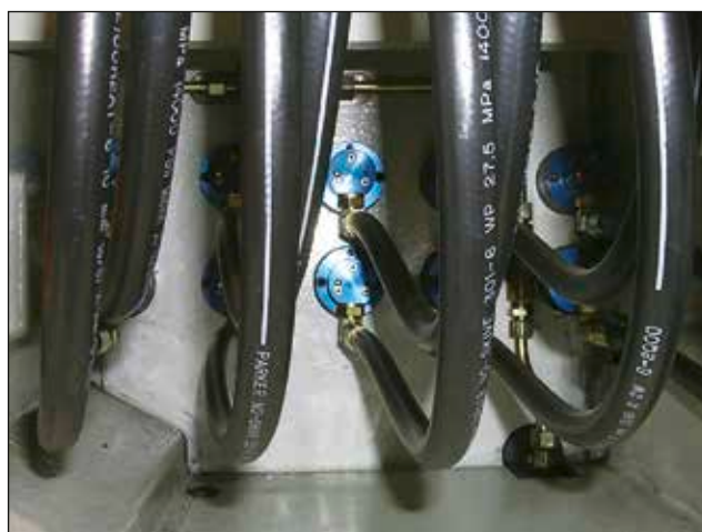
Złącza samonośne DEUBLIN 1117 na linii obróbkowej w fabryce podzespołów samochodowych
